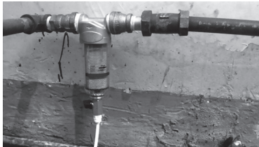
图1 循环水过滤装置
