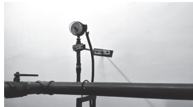
图4 压力表加固装置
